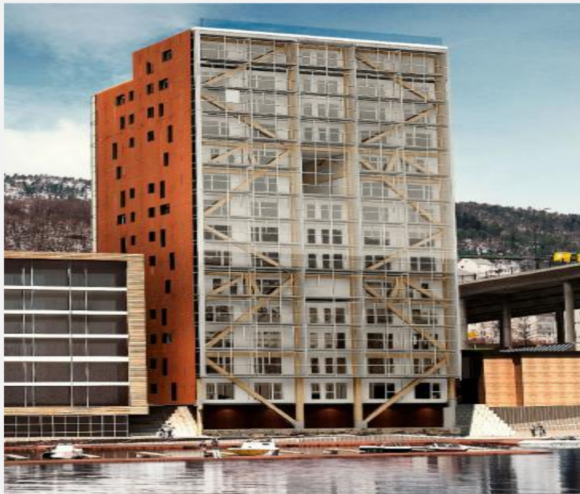
梁柱框架木结构，总高49.9m
